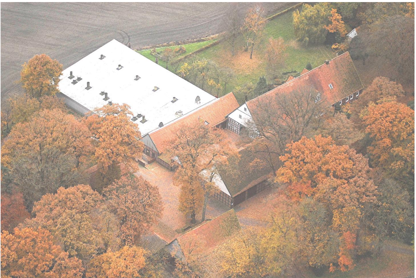
Die denkmalgeschützte Hofanlage große Beilage
